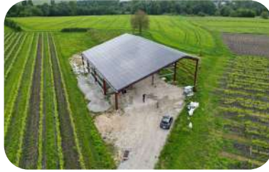
La Pouyade (17) - 133 kWc de puissance installée
