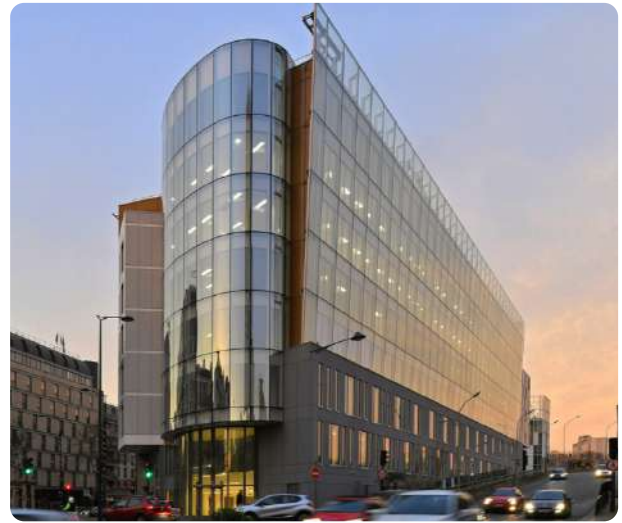
Siège d'Orion Energies - Batiment E-conic - CLICHY
