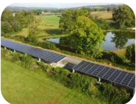
Ombrières de parking
