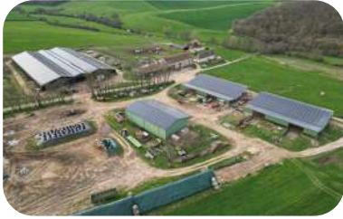
Le Vernay (58) - 998 kWc de puissance installée
