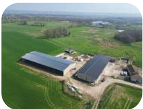
Centrales solaires en toitures
